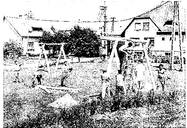
A játékok tartóoszlopainak felállítása, rögzítése kalákában, szakemberek segítségével.
